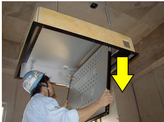
1. セラミックパネルのフックをかける
