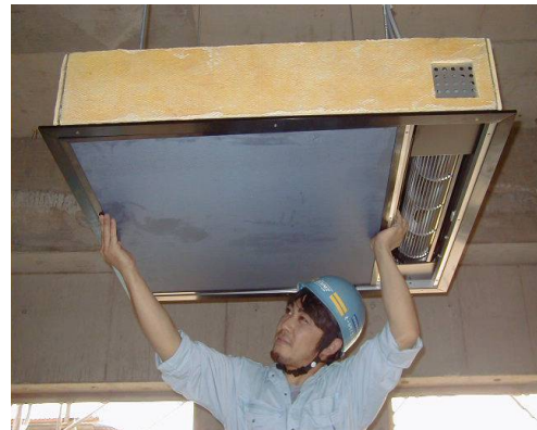
4. セラミックパネルをセラミックパネルをファン側へ 約3cmスライドさせ固定させる
