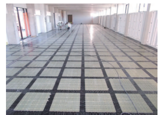
12. ネットワークフロア敷設完了
