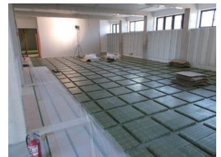
8. ベースマット敷設
