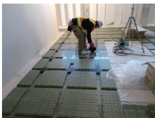
9. 配線路カバー敷設
