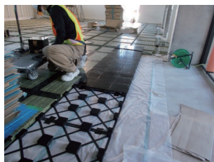
10. フィードインマット・フィードインカバー敷設
