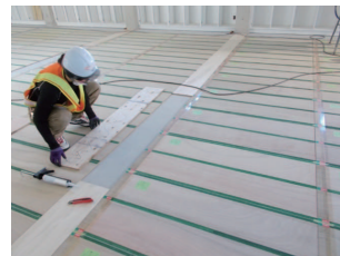
7. 床暖房周辺合板敷設
