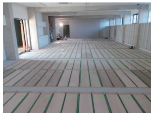
6. 床暖房設置完了
